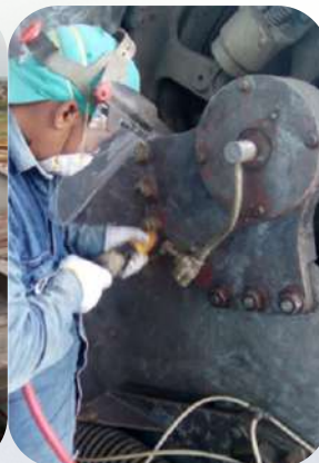
Limpeza Manual mecánica con grado SSPC-SP-1/2/3/11
