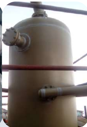
Aplicación de recubrimientos sobre equipos de proceso
