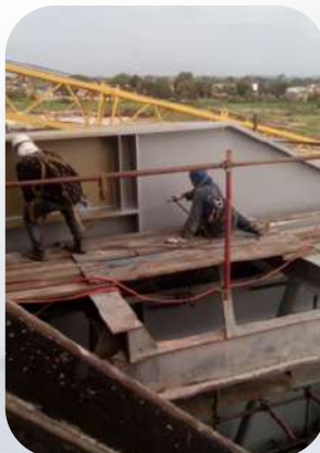
Aplicación de recubrimientos sobre estructuras metálicas
