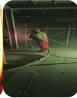
Limpeza con arenado seco con grado SSPC-SP-6
