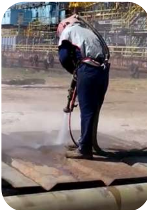
Limpeza con arenado húmedo con grado SSPC-SP-6
